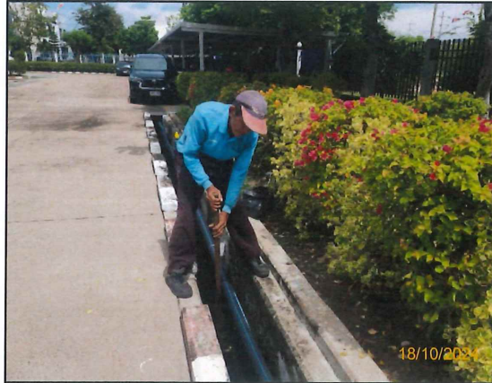
ภาพที่ 2.2-16 การทำความสะอาดรางระบายน้ำ
