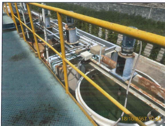
ระบบบำบัดน้ำเสียปนเปื้อนโพรเซส
