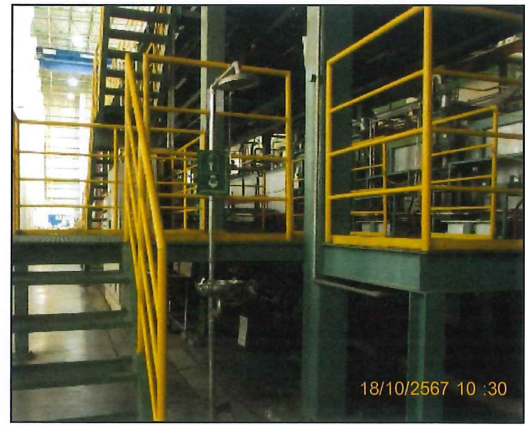
ภาพที่ 2.2-20 ฝักบัวล้างตัวและอ่างล้างตาฉุกเฉิน
