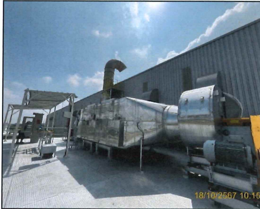
ภาพที่ 2.2-2 ระบบบำบัดอากาศแบบ Selective Catalytic Reduction (SCR)
