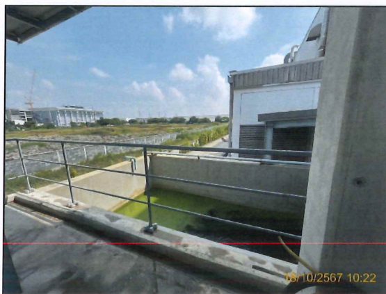
บ่อพักน้ำทิ้งขนาด 107 ลูกบาศก์เมตร
