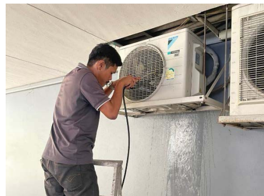
ดูแลตรวจสอบเครื่องปรับอากาศ และทำการล้างเครื่องปรับอากาศ
