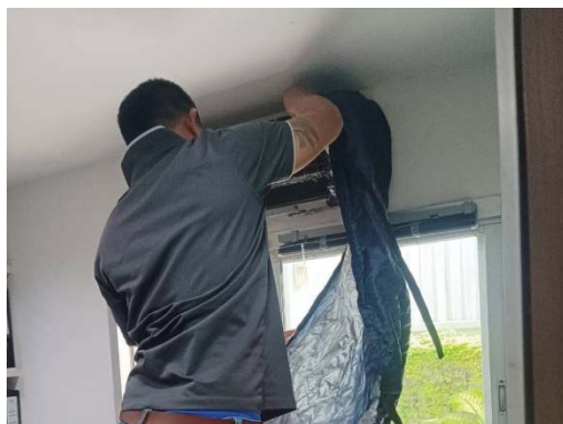
ดูแลตรวจสอบเครื่องปรับอากาศ และทำการล้างเครื่องปรับอากาศ
