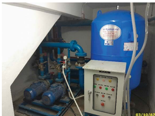
เครื่องปั้มน้ำชั้นดาดฟ้า และ Booster Pump
