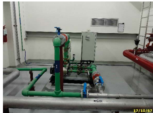
Booster Pump ชั้นห้องเครื่องลิฟต์
