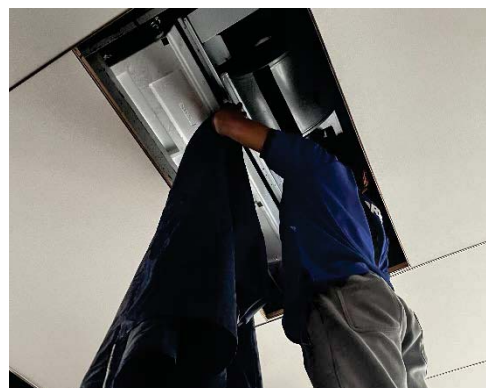
เจ้าหน้าที่ทำความสะอาดเครื่องปรับอากาศ
