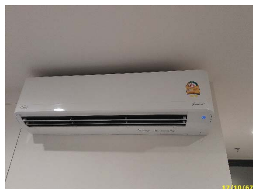
เครื่องปรับอากาศแบบแยกส่วน
