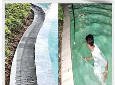
งานเพิ่มตะแกรงกันใบไม้ลงในบ่อน้ำบริเวณสระว่ายน้ำ / งานขัดขอบสระกระเบื้องสระใหญ่
