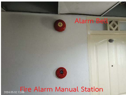
Fire Alarm Manual Station และ Alarm Bell
