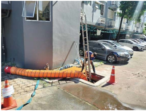
ภาพที่ 2-8 (ต่อ) เจ้าหน้าที่ตรวจสอบระบบประปา และ ล้างถังเก็บน้ำ
