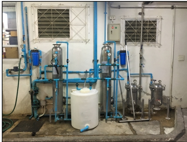
ภาพที่ 2-12 ระบบกรองน้ำเพื่อใช้บริโภค
