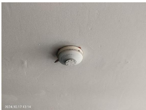
ตรวจจับความร้อน (Heat Detector)
