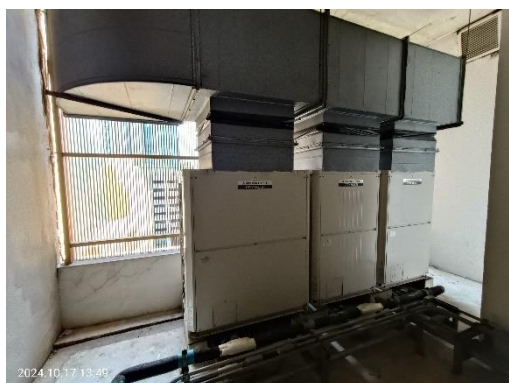
เครื่องปรับอากาศแบบ VRF
