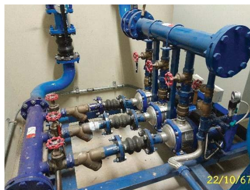
ปั๊มระบบถังอัดแรงดัน (Booster Pump)
