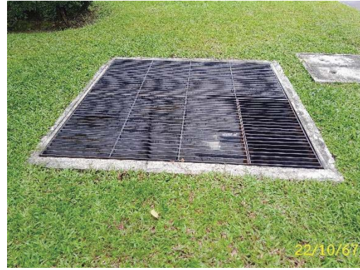
บ่อพักน้ำ (Manhole)
