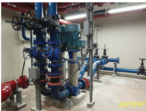
เครื่องสูบน้ำ (Cold Water Pump)
