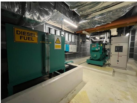
รูปที่ 2-21 เครื่องกำเนิดไฟฟ้าฉุกเฉิน ส่วนโรงแรม
