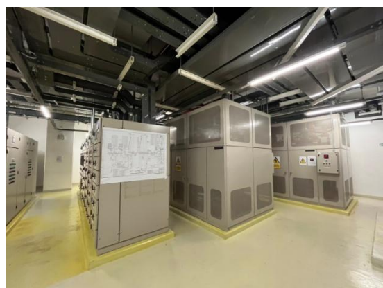
รูปที่ 2-18 หม้อแปลงไฟฟ้า ส่วนสำนักงาน
