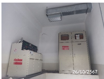
Ring Main Unit การไฟฟ้านครหลวง
