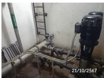
Transfer Pump ชั้นที่28 และชั้นที่47
