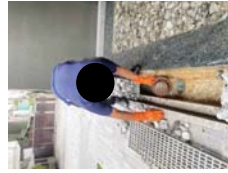
การทำความสะอาดระบบระบายน้ำ
