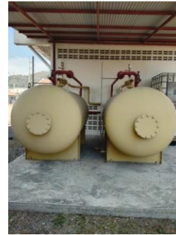
ระบบโฟมดับเพลิง (Fixed Foam System) จำนวน 7,530 ลิตร
