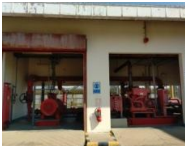
ระบบปั้มน้ำดับเพลิง (Fire Pump) จำนวน 2 ชุด
