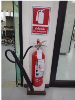
ถังดับเพลิงผงเคมีแห้งชนิดมือถือ ขนาด 15 ปอนด์ จำนวน 24 ถัง
