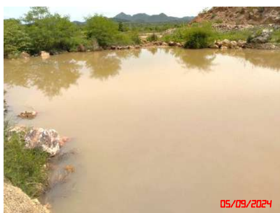
รูปที่ 13 บ่อดักตะกอนของโครงการ
