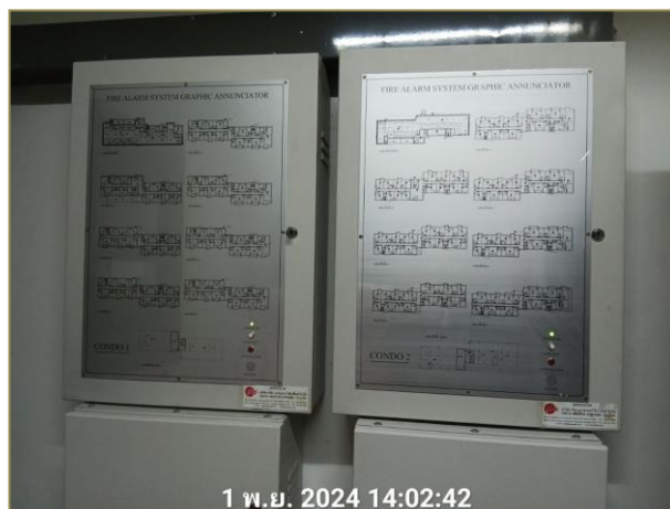
รูปที่ 2.26 แผงควบคุม FPC
