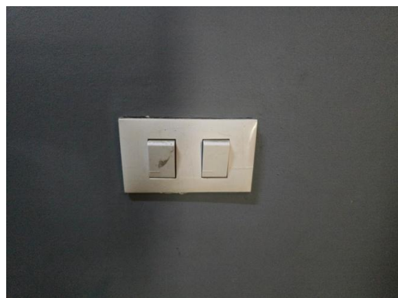
รูปที่ 2-27 สวิตช์แยกเพื่อเปิด-ปิดไฟในจุดที่ไม่มีการใช้งาน
