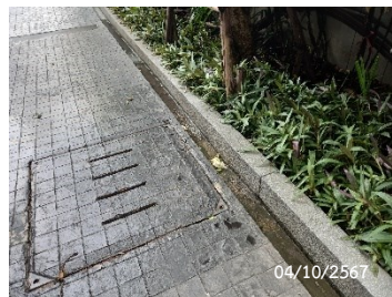
รางระบายน้ำ และบ่อพักน้ำฝนรอบโครงการ
