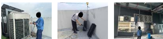
การทำความสะอาดเครื่องปรับอากาศ
