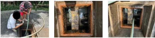
การสูบลบไขมันจากระบบบำบัดน้ำเสีย
