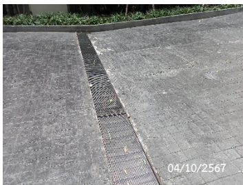
รางระบายน้ำ และบ่อพักน้ำฝนรอบโครงการ
