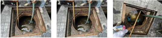
การสูบลบคอนกรีตส่วนเกินจากระบบบำบัดน้ำเสีย
