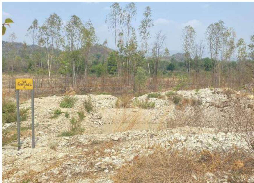
รูปที่ 6 แสดงบ่อดักตะกอนภายในเขตพื้นที่โครงการฯ
