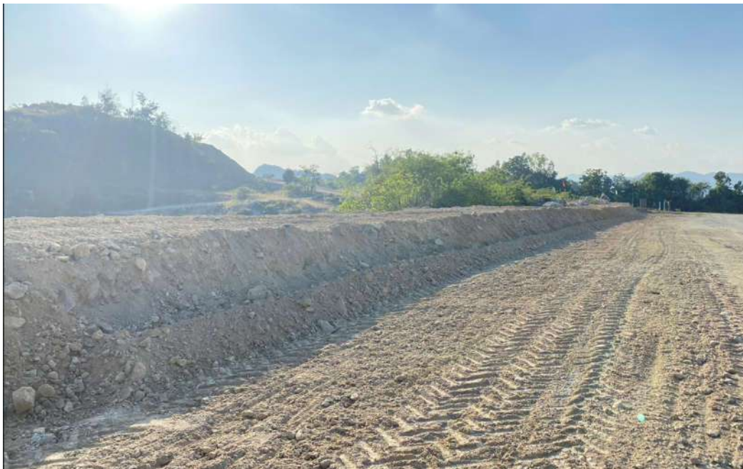
รูปที่ 4 แสดงคันทำนบดินอัดแน่นกั้นบังกิจกรรมภายในเขตพื้นที่โครงการฯ
