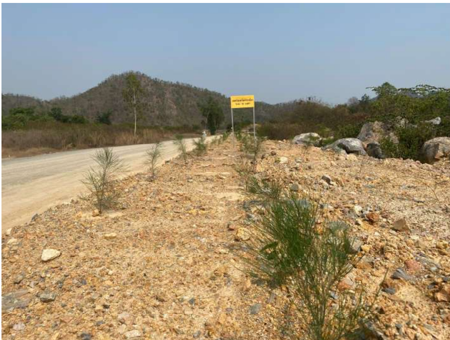
รูปที่ 13 แสดงคันทำนบดินพร้อมทั้งการปลูกพืชเป็นฉากกั้นกิจกรรมภายในเขตพื้นที่โครงการฯ
