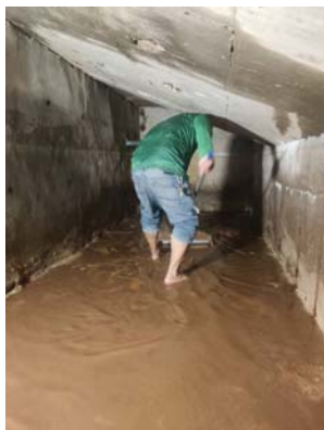
การล้างทำความสะอาดถังสำรองน้ำใช้
