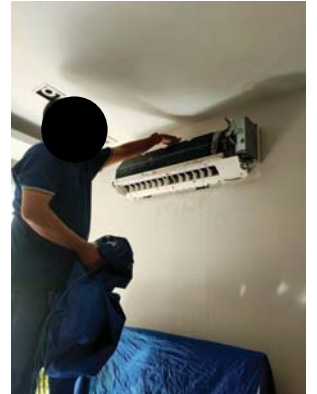
การล้างทำความสะอาดเครื่องปรับอากาศ
