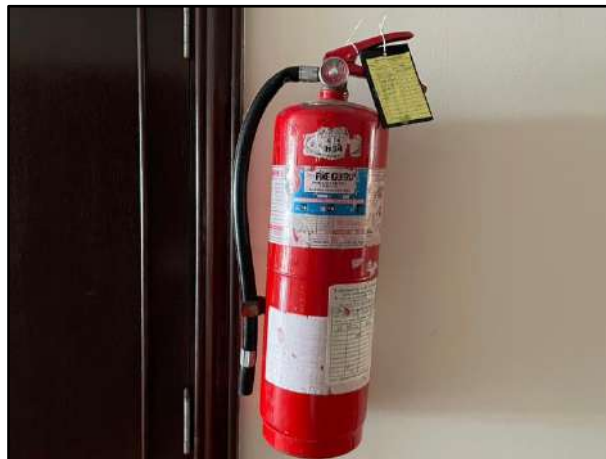
รูปที่ 1.7 เครื่องดับเพลิงชนิดมือถือ
