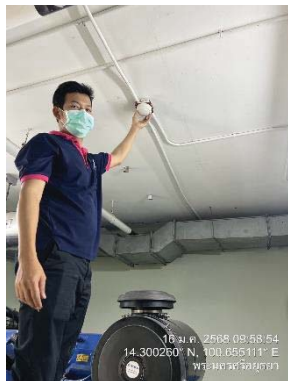
ตรวจสอบ Heat Detector
