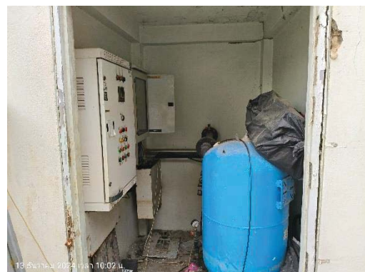
ตู้ควบคุมการสูบน้ำในบ่อน้ำผิวน้ำ
