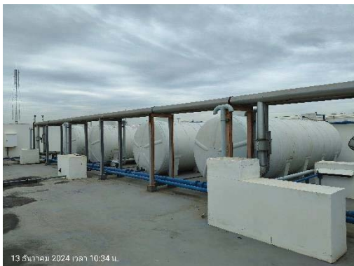
ถังเก็บน้ำใช้ ชั้นหลังคา
