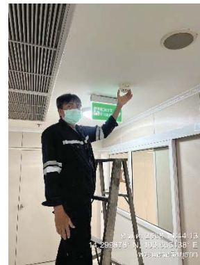
ตรวจสอบ Smoke Detector
