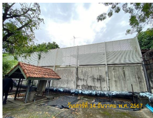
ภาพที่ 2-3 รั้วอิฐบล็อกจากความสูงประมาณ 3 เมตร และเพิ่มระแนง PVC ประมาณ 2 เมตร บริเวณที่ติดกับชุมชนและวัดคุณแม่จันทร์
