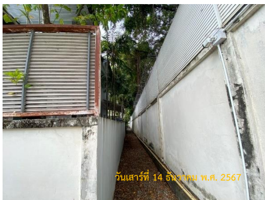
ภาพที่ 2-3 รั้วอิฐบล็อกจากความสูงประมาณ 3 เมตร และเพิ่มระแนง PVC ประมาณ 2 เมตร บริเวณที่ติดกับชุมชนและวัดคุณแม่จันทร์
