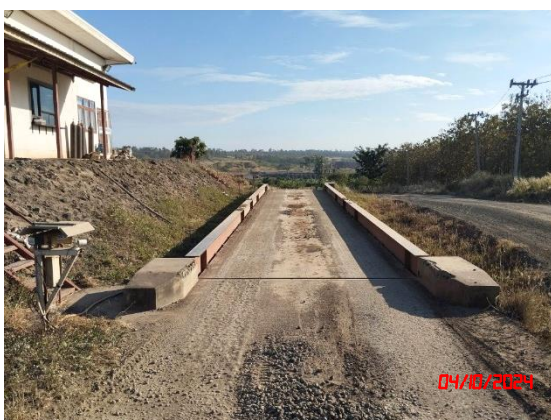
รูปที่ 16 จุดขังน้ำหน้ากรบรถบรรทุก
