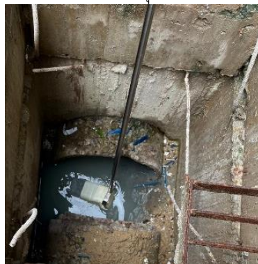
รูปที่ 3.17 การเก็บตัวอย่างคุณภาพน้ำทั้ง บริเวณระบบบำบัดน้ำเสียสำเร็จรูป
