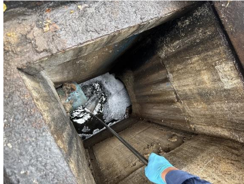
จุดที่ 3 ภาพก่อนปล่อยออกสู่ภายนอกโครงการ : บ่อพักน้ำสุดท้ายพร้อมตะแกรงดักขยะ
