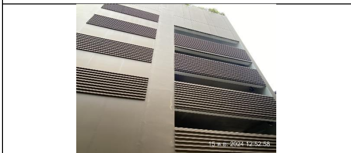
รูปที่ ๗7.6 ช่องระบายอากาศบริเวณที่จอดรถ
