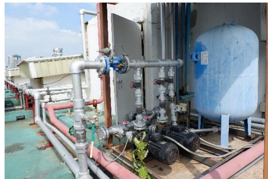
ภาพที่ 2-5 ช่องชาร์ปน้ำประปาและระบบน้ำใช้ภายในโครงการ
