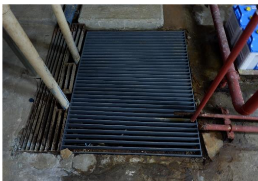
ภาพที่ 2-6 รางระบายน้ำและการป้องกันน้ำท่วมภายในโครงการ
