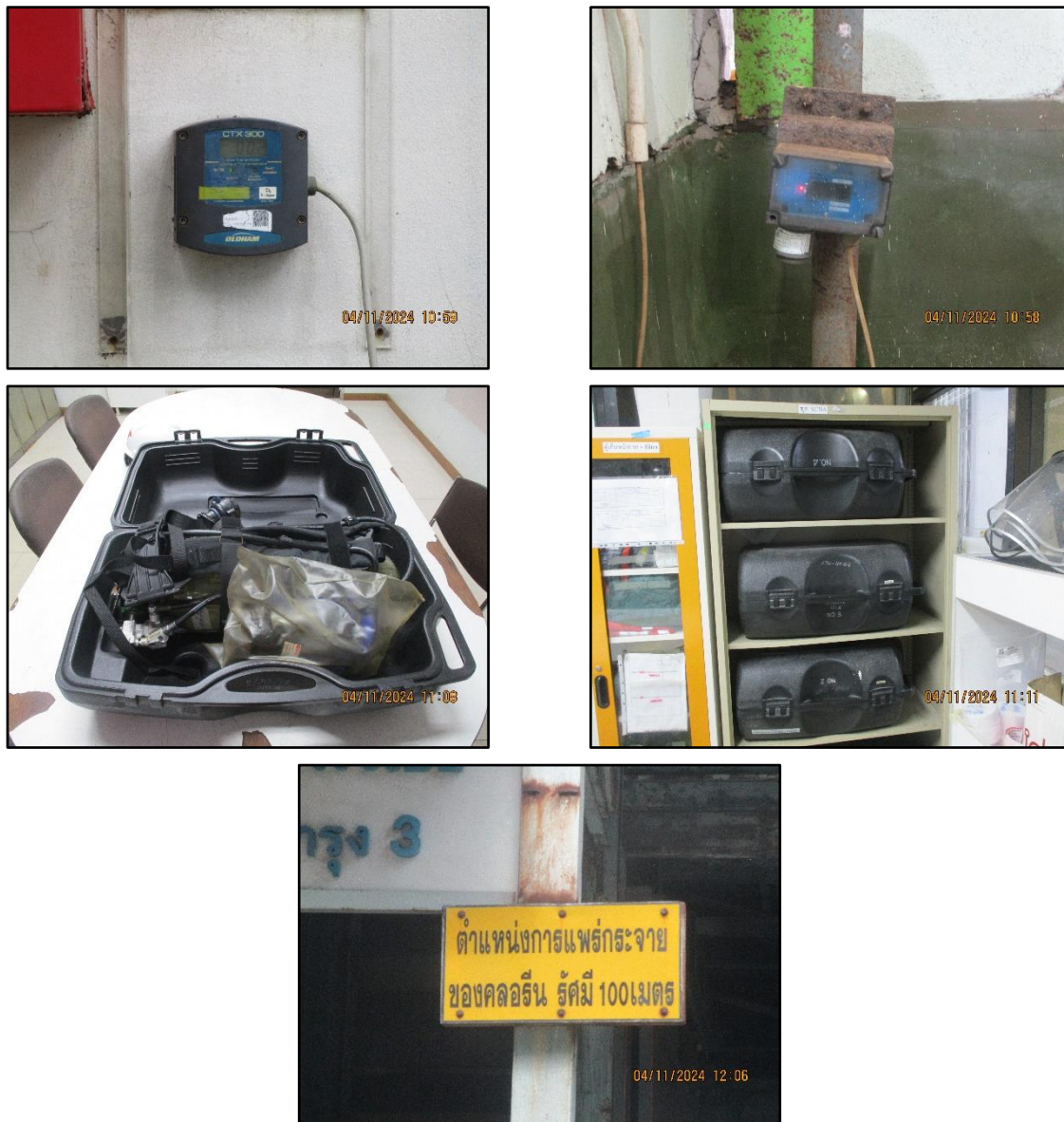
ภาพที่ 2.29 อุปกรณ์ตรวจจับและระงับเหตุคลอรีนรั่วไหล
