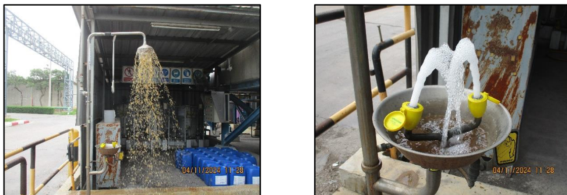
ภาพที่ 2.30 ฝักบัวฉุกเฉินภายนอกและภายในตัวอาคาร
