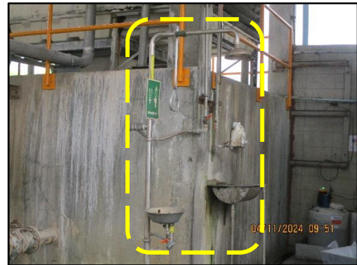
ภาพที่ 2.30 (ต่อ) ฝักบัวฉุกเฉินภายนอกและภายในตัวอาคาร
