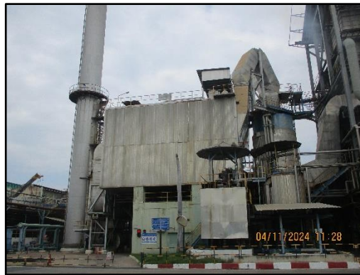
ภาพที่ 2.7 ระบบดักฝุ่นแบบไฟฟ้าสถิตย์ (Electrostatic Precipitators : EP)
