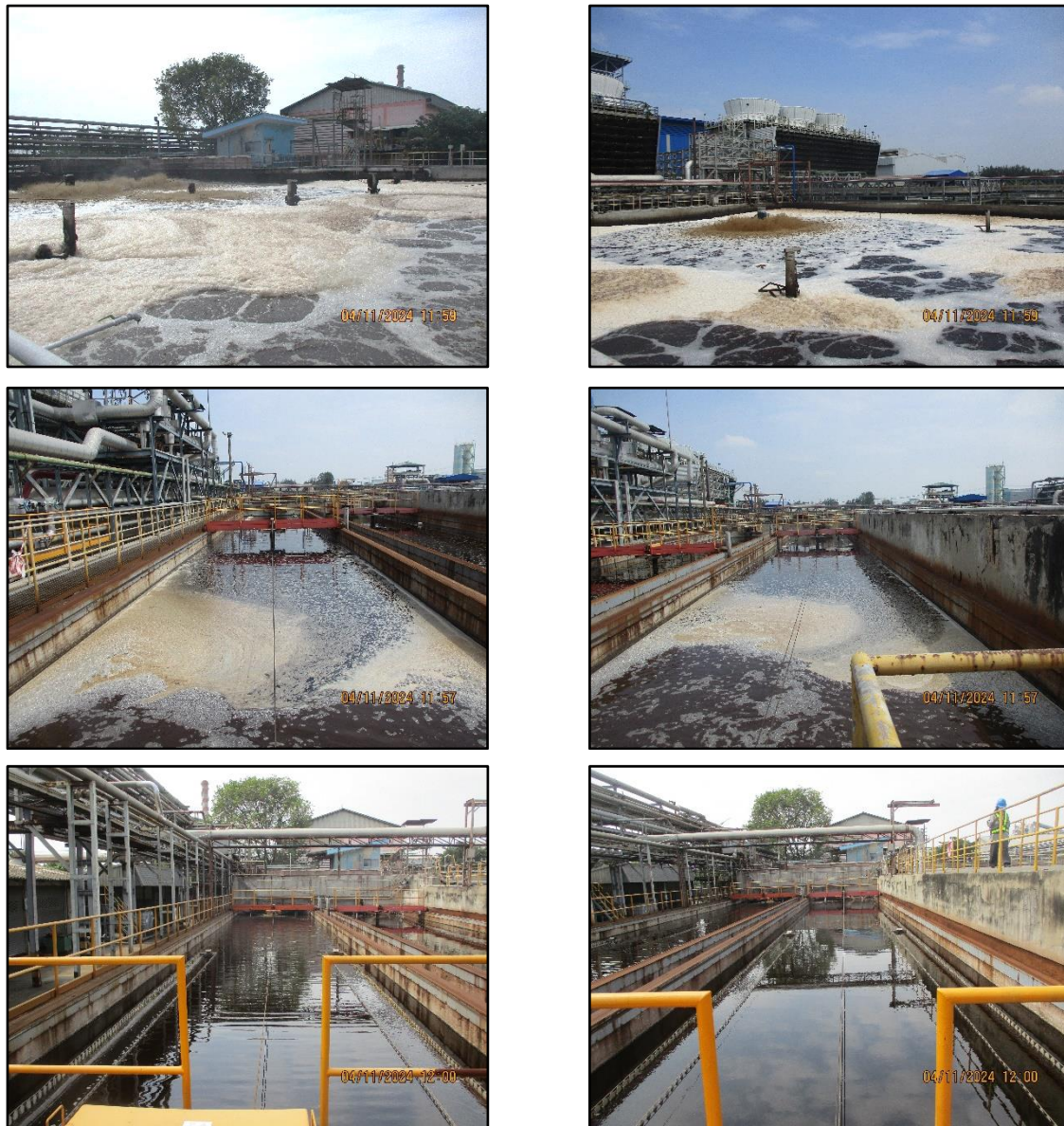
ภาพที่ 2.1 ระบบบำบัดน้ำเสียแบบ Activated Sludge
