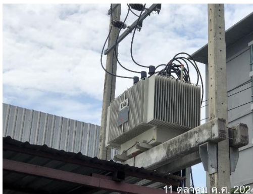
รูปที่ 35 หม้อแปลงและมิเตอร์ไฟฟ้าชั่วคราว
