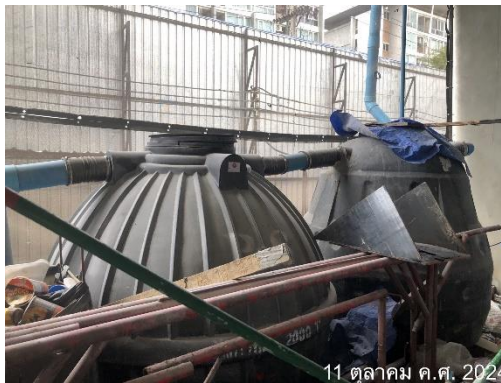
รูปที่ 23 ถังบำบัดน้ำเสียสำเร็จรูป
