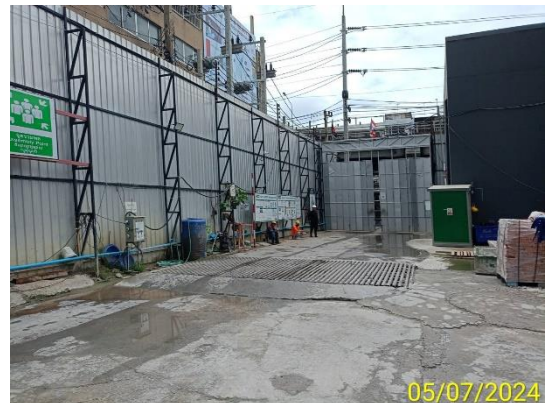
รูปที่ 7 จุดล้างล้อรถก่อนออกจากโครงการ
