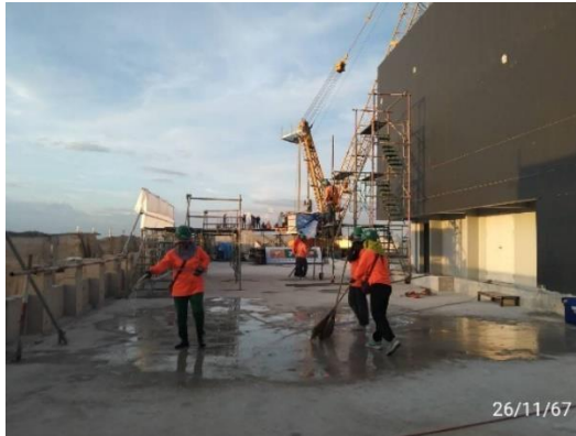
รูปที่ 6 การฉีดพรมน้ำเพื่อลดฝุ่น
