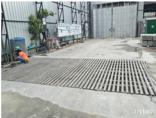
รูปที่ 7 จุดล้างล้อรถก่อนออกจากโครงการ
