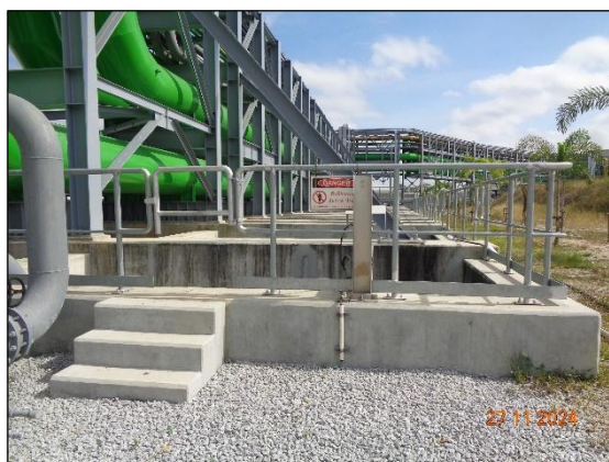
รูปที่ 2-9 บ่อพักน้ำทิ้งฉุกเฉิน (Emergency Pit)
