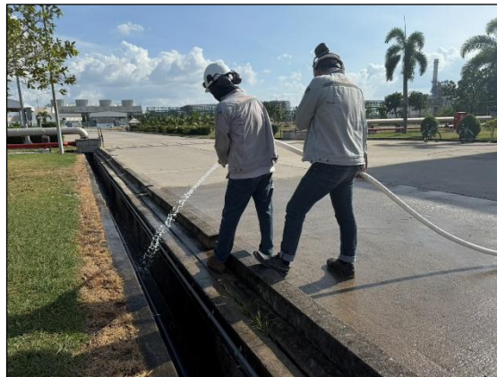
รูปที่ 2-19 การทำความสะอาดทางระบายน้ำต่างๆ
