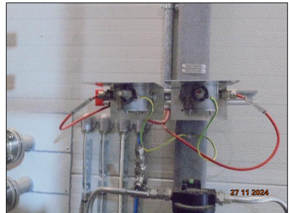
ระบบตรวจจับก๊าซรั่วไหล
