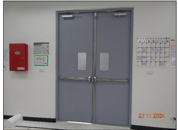
รูปที่ 2-14 ประตูและผนังที่บั่นเสียงสำหรับห้องควบคุม
