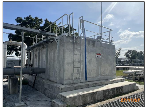
รูปที่ 2-10 บ่อตรวจสอบคุณภาพน้ำทิ้ง (Inspection Pit)
