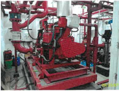
เครื่องสูบน้ำเพื่อการดับเพลิงชั้นใต้ดิน
