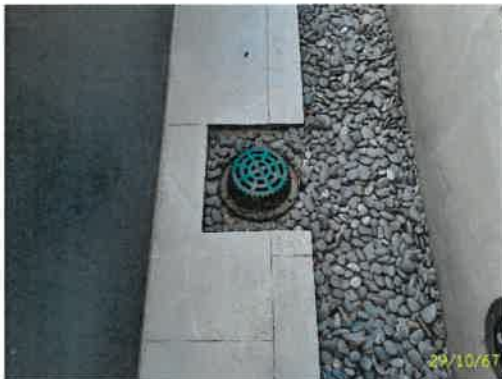
ภาพที่ 2.2-24 ตะแกรงครอบรูท่อระบายน้ำ
