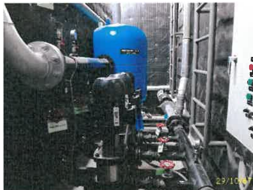
เครื่องสูบน้ำเพื่อการอุปโภค-บริโภค ชั้นคาตฟ้า
