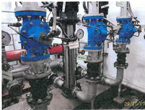
เครื่องสูบน้ำเพื่อการอุปโภค-บริโภคชั้นใต้ดิน
