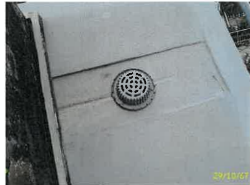
ภาพที่ 2.2-24 ตะแกรงครอบรูท่อระบายน้ำ
