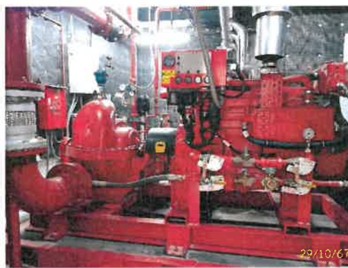
เครื่องสูบน้ำดับเพลิงชั้นที่ 34
