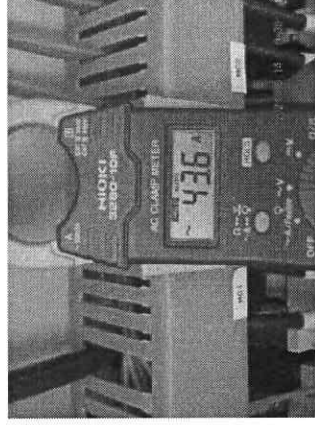
รูปที่ 57 กระแสมอเตอร์เฟส S ที่อ่านค่าได้เท่ากับ 43.6 Amp.
