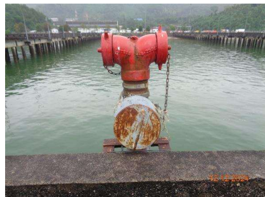
รูปที่ 1-5 ระบบดับเพลิงภายในโครงการ
