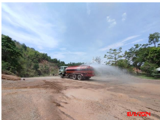
รูปที่ 11 การฉีดพรมน้ำบริเวณเส้นทางขนส่งแร่
