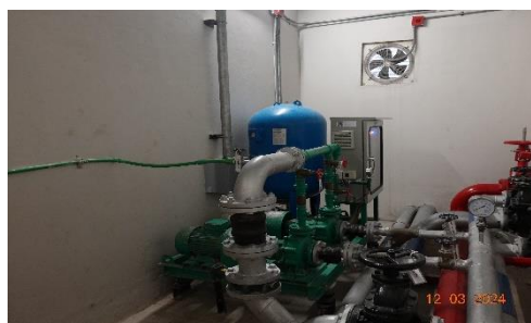
ถังเก็บน้ำชั้นดาดฟ้า และเครื่องปั้มน้ำ
