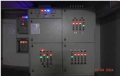
พื้นที่ระบบบำบัดน้ำเสีย พร้อมตู้ควบคุมระบบบำบัดน้ำเสีย
