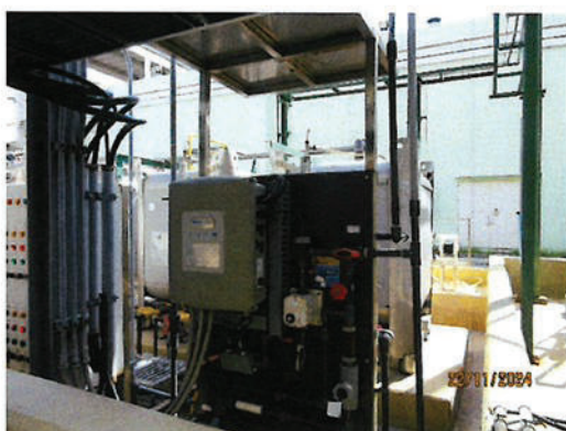
รูปที่ 2-5 การติดตั้ง ORP Analyzer ที่ระบบ Cooling Water System
