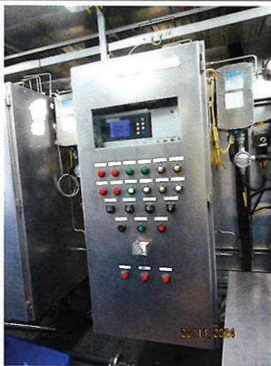
รูปที่ 2-1 ระบบ CEMs ที่ปล่อย H-100H
