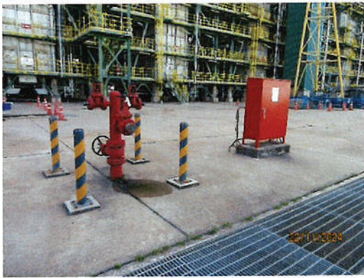
หัวจ่ายน้ำดับเพลิง (Fire Hydrant)
