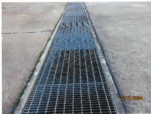
รูปที่ 2-9 ระบบระบายน้ำฝน
