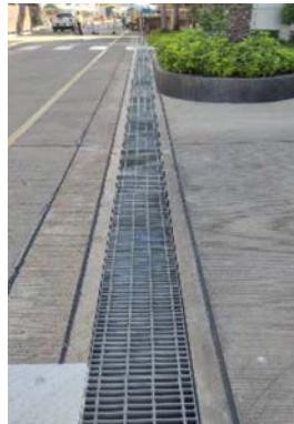
รูปที่ 2-28 รางระบายน้ำของโครงการ
