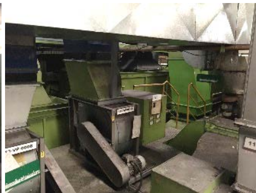
รูปที่ 2-6 ระบบรวบรวมฝุ่นและระบบบำบัดมลพิษทางอากาศจากห้อง Buff
