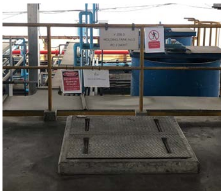
รูปที่ 2-19 ตำแหน่งบ่อ Holding Pond ขนาด 350 ลูกบาศก์เมตร/วัน
