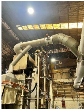
รูปที่ 2-5 ระบบรวบรวมฝุ่นจากเตาหลอมและระบบบำบัดมลพิษทางอากาศอาคาร DC5
