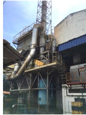
รูปที่ 2-5 ระบบรวบรวมฝุ่นจากเตาหลอมและระบบบำบัดมลพิษทางอากาศอาคาร DC5
