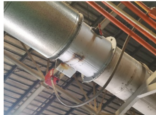
รูปที่ 2-10 การติดตั้งวาล์วควบคุมการไหล
