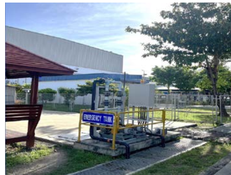
รูปที่ 2-20 บ่อพักน้ำทิ้งฉุกเฉิน ขนาด 350 ลูกบาศก์เมตร/วัน
