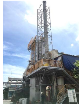
รูปที่ 2-3 ระบบรวบรวมฝุ่นจากเตาหลอมและระบบบำบัดมลพิษทางอากาศอาคาร DC3
