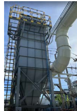
รูปที่ 2-6 ระบบรวบรวมฝุ่นและระบบบำบัดมลพิษทางอากาศจากห้อง Buff
