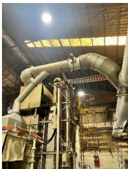
รูปที่ 2-3 ระบบรวบรวมฝุ่นจากเตาหลอมและระบบบำบัดมลพิษทางอากาศอาคาร DC3
