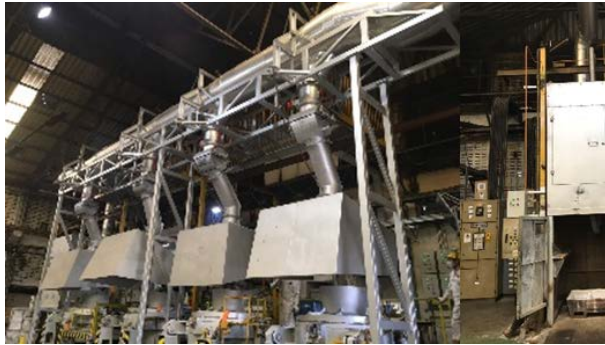
รูปที่ 2-1 ระบบรวบรวมฝุ่นจากเตาหลอมและระบบบำบัดมลพิษทางอากาศ อาคาร DC1
