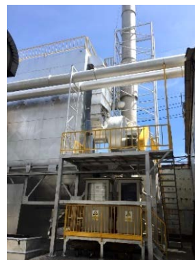
รูปที่ 2-4 ระบบรวบรวมฝุ่นจากเตาหลอมและระบบบำบัดมลพิษทางอากาศอาคาร DC4
