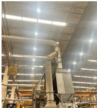
รูปที่ 2-2 ระบบรวบรวมฝุ่นจากเตาหลอมและระบบบำบัดมลพิษทางอากาศอาคาร DC2
