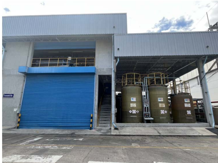
รูปที่ 2-18 ระบบบำบัดน้ำเสียทางเคมี ขนาด 350 ลูกบาศก์เมตร/วัน (ต่อ)
