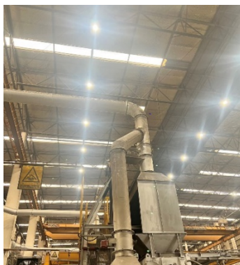
รูปที่ 2-4 ระบบรวบรวมฝุ่นจากเตาหลอมและระบบบำบัดมลพิษทางอากาศอาคาร DC4
