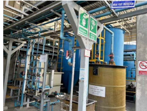
รูปที่ 2-44 ฝักบัวฉุกเฉินและอ่างล้างตาฉุกเฉิน
