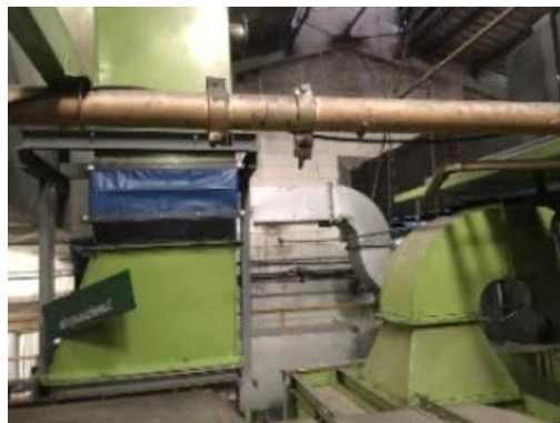
รูปที่ 2-7 ระบบรวบรวมอากาศภายในอาคาร Painting
