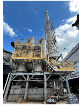
รูปที่ 2-1 ระบบรวบรวมฝุ่นจากเตาหลอมและระบบบำบัดมลพิษทางอากาศ อาคาร DC1
