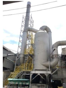
รูปที่ 2-2 ระบบรวบรวมฝุ่นจากเตาหลอมและระบบบำบัดมลพิษทางอากาศอาคาร DC2
