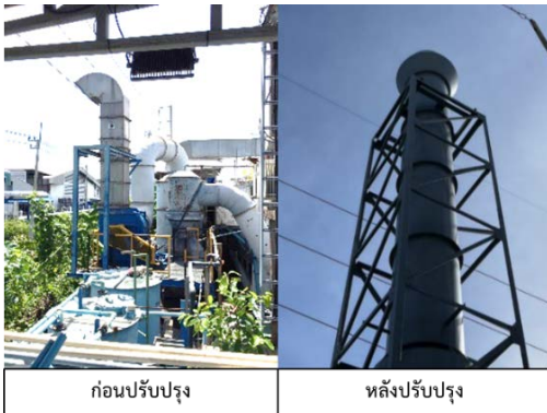
รูปที่ 2-9 การปรับปรุงปล่องระบายมลพิษทางอากาศ ห้อง Buff
