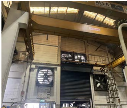
รูปที่ 2-12 การติดตั้งพัฒนาระบายอากาศในอาคาร DC1, DC2, DC4 และ DC5
