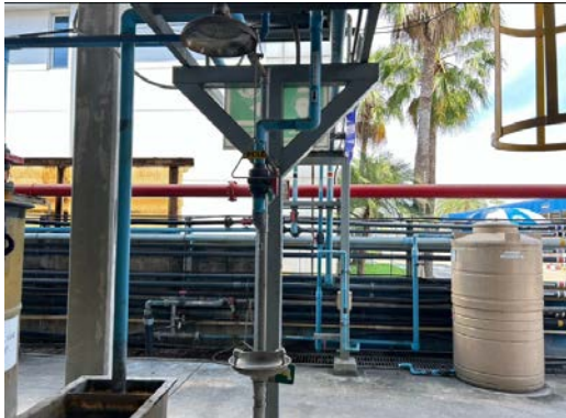
รูปที่ 2-44 ฝักบัวฉุกเฉินและอ่างล้างตาฉุกเฉิน
