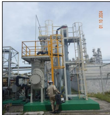
ปล่องระบายที่ออกจากหอดูดซับด้วยถ่านกัมมันต์ของบ่อรวบรวมน้ำเสีย
