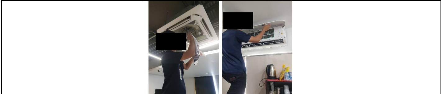
รูปที่ ผ7.69 การล้างแผ่นกรองอากาศของเครื่องปรับอากาศในพื้นที่ส่วนกลาง
