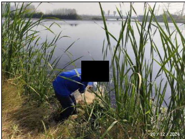
รูปที่ 2-9 การเติมจุลินทรีย์ในบ่อบำบัดน้ำเสีย
