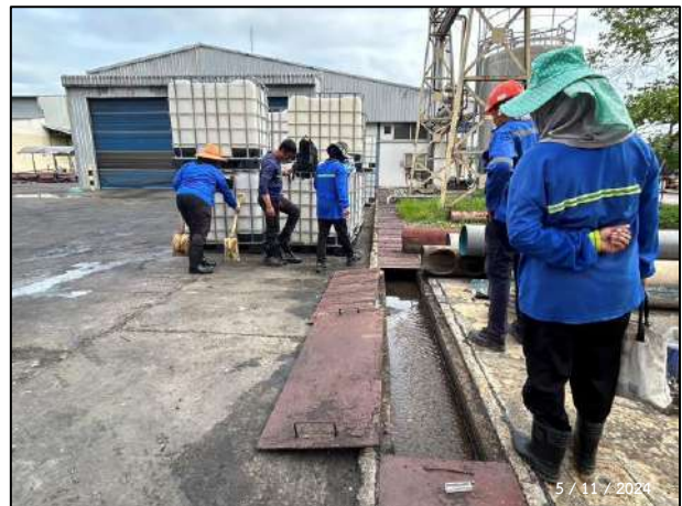
รูปที่ 2-17 กิจกรรมขุดลอกระบบท่อ / รางระบายน้ำเสีย
