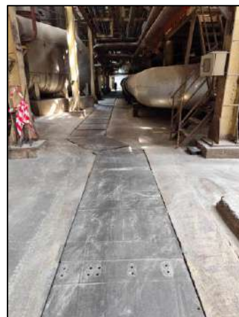
รางรวบรวมน้ำฝนปนเปื้อน
