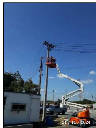
รูปที่ 2-53 การตรวจสอบ ทำความสะอาดหลอดไฟ
