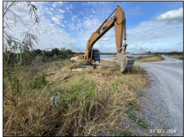
รูปที่ 2-24 กิจกรรมตรวจสอบซ่อมบำรุงคันเก็บน้ำดิบ
