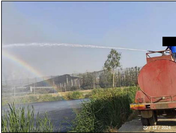
รูปที่ 2-7 การเติมปูนขาวในบ่อพักน้ำเสียโครงการ
