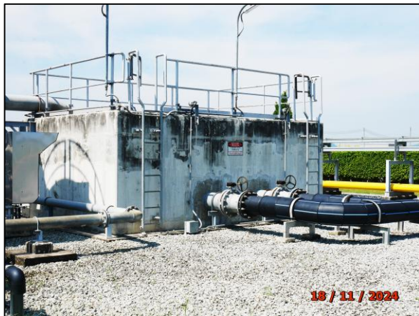
รูปที่ 2.12 ปอดตรวจสอบคุณภาพน้ำทิ้ง
