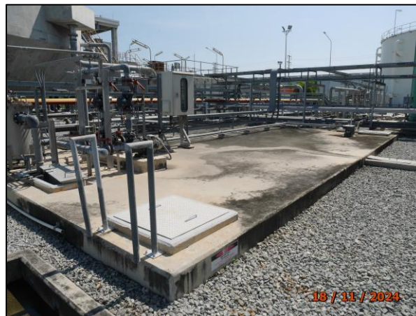
รูปที่ 2.15 ปอดปรับสภาพความเป็นกรด-ด่าง (Neutralization Pit)
