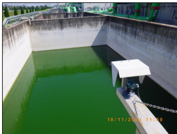
รูปที่ 2.14 ปอดน้ำทิ้งฉุกเฉิน (Emergency Pit)
