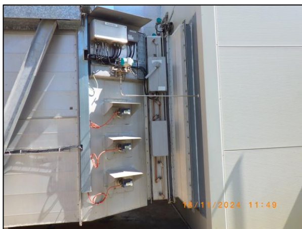
รูปที่ 2.27 ระบบป้องกันการรั่วซึมของก๊าซ (Gas Detector บริเวณ Gas Turbine) (ต่อ)
