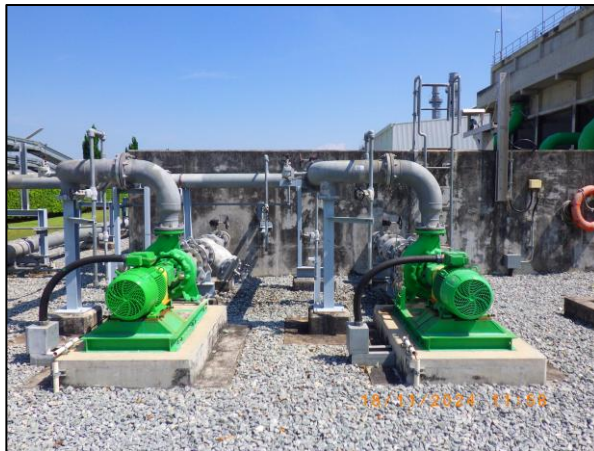
รูปที่ 2.8 ฐานคอนกรีตลดแรงสั่นสะเทือน
