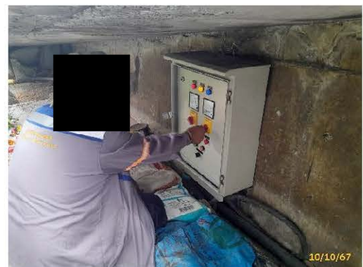
การตรวจสอบการทำงานของเครื่องจักรในระบบระบายน้ำ
