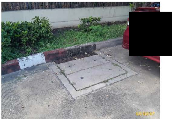
ตะแกรงดักขยะบริเวณฝาท่อระบายน้ำ
