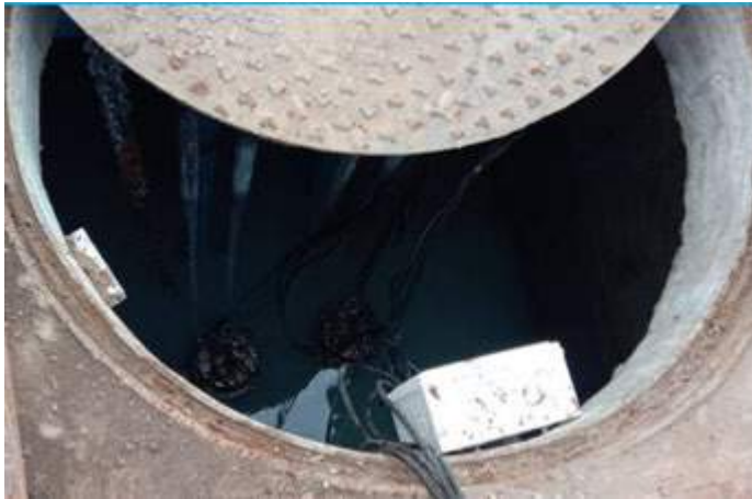
ภาพที่ 2-3(3.3-2) ช่างอาคารตรวจเช็คและบำรุงรักษาระบบบำบัดน้ำเสีย เดือนละ 1 ครั้ง
