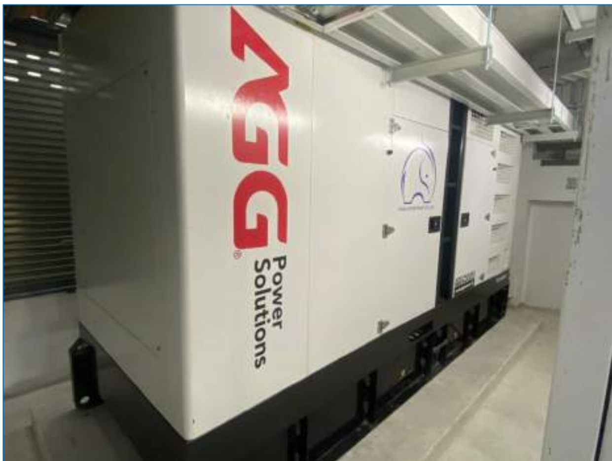
ภาพที่ 3-8(8.2) ช่างอาคารตรวจเช็ค ห้อง Generator เครื่องสำรองไฟฟ้า ทุกวัน และ test run ระบบทุกวันพุธ เวลา 10.00 น. ประมาณ 15 นาที
