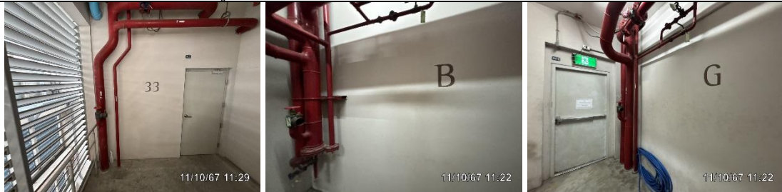
รูปที่ ผ7.41 ท่อยื่นรับน้ำดับเพลิง
