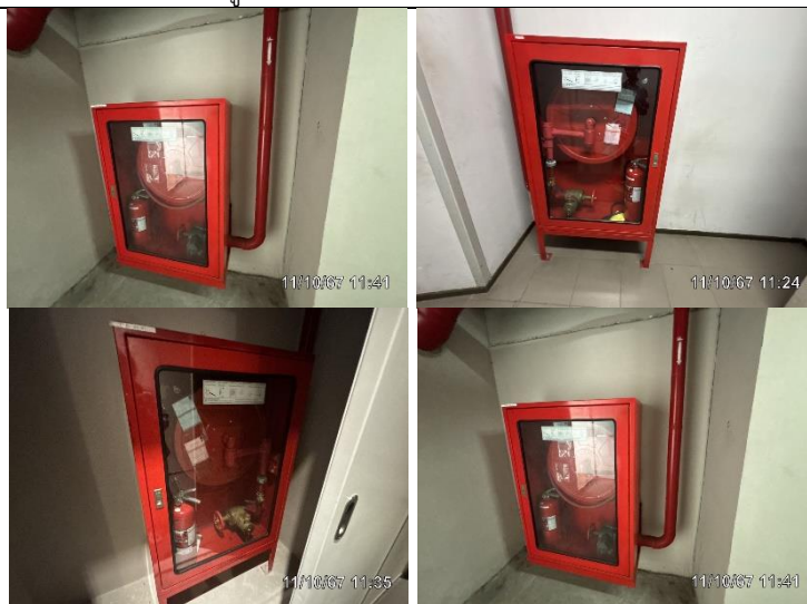
รูปที่ ผ7.43 ตู้เก็บสายฉีดน้ำดับเพลิงพร้อมอุปกรณ์ (FHC) และวิธีการใช้อุปกรณ์
