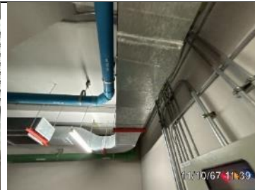
รูปที่ ผ7.5 พัดลมระบายอากาศ (Fan Exhaust) บริเวณชั้นใต้ดิน
