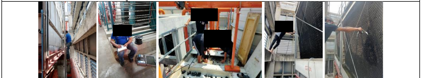
รูปที่ ผ7.59 เจ้าหน้าที่เข้าทำความสะอาดและกำจัดตะกอนในหอผึ่งเย็น
