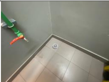
รูปที่ ผ7.67 ตะแกรงครอบตามรูท่อระบายน้ำ
