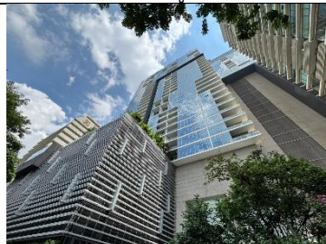
รูปที่ ผ7.38 กระจกสีตัดแสง (Low Shading)
