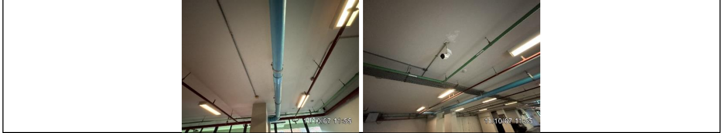
รูปที่ ผ7.30 ท่อรวมรวมน้ำจากการล้างห้องพัสดุฝอย
