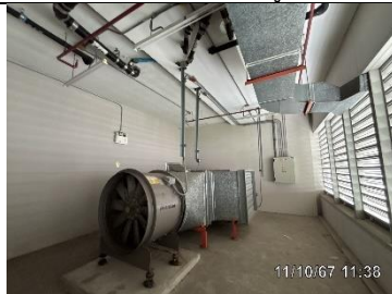
รูปที่ ผ7.5 พัดลมระบายอากาศ (Fan Exhaust) บริเวณชั้นใต้ดิน
