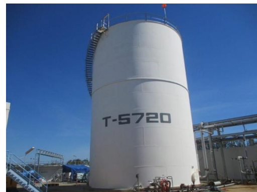
รูปที่ 3-14 Ballast Tank (T-5720) รวบรวม น้ำเสียปนเปื้อนน้ำมันจากเรือ
