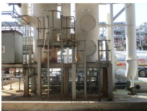
รูปที่ 3-36 Sulfur Scrubber
