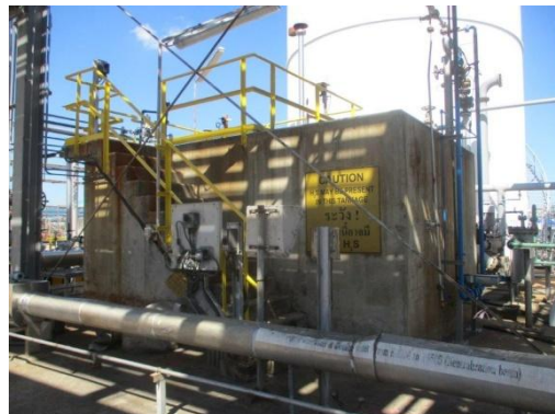
ระบบ Neutralization Basin
