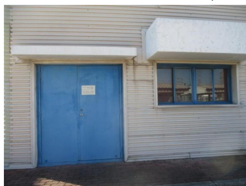
รูปที่ 3-11 การปิดครอบเพื่อลดระดับเสียง ที่แหล่งกำเนิด
