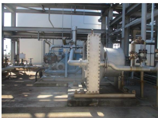
รูปที่ 3-17 เครื่องอัดอากาศ (Compressor) ของถัง H 2 S Oxidation (K5502)
