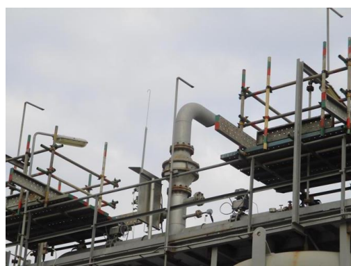
รูปที่ 3-9 อุปกรณ์ตรวจวัดที่ VRU ที่สถานีขนถ่ายน้ำมันทางรถบรรทุก
