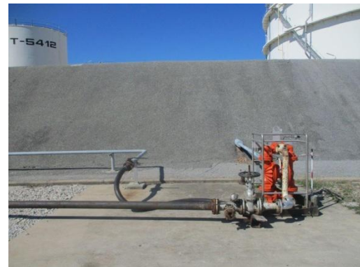
รูปที่ 3-52 วาล์วนิรภัยบริเวณท่อลำเลียง คอนเดนเสทและรีฟอร์มเมอร์
