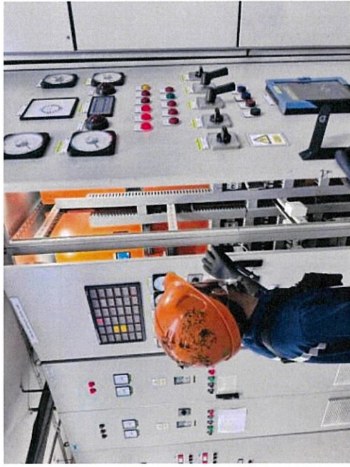
พนักงานไฟฟ้าเข้ารับเหตุเบื้องต้น โดยสวมถุงมือป้องกัน ไฟดูด ก่อนเปิดตู้ 27 MW. 6.6KV GENERATOR CONTROL PANEL เพื่อใช้ดับเพลิงดับไฟ
