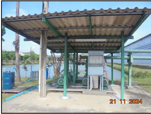
รูปที่ 5 การสูบน้ำจากคลองชลประทาน (คลองส่งน้ำสายสิบสองซ้าย)
