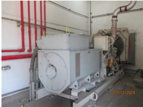
รูปที่ 3-64 Generator Backup
