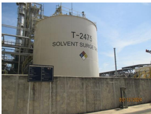
รูปที่ 3-62 กำแพงกั้นบริเวณถังเก็บสารเคมี
