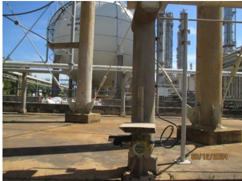
รูปที่ 3-70 Gas Detector บริเวณลานถังเก็บ
