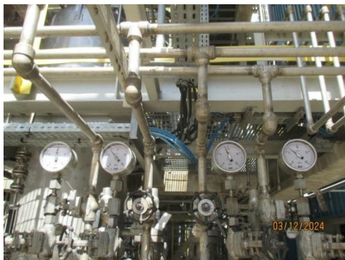
รูปที่ 3-72 อุปกรณ์วัดความดัน (Pressure Indicator) ในพื้นที่กระบวนการผลิต
