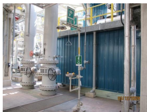
รูปที่ 3-56 อ่างล้างตา ฝักบัวล้างตา และที่ชำระล้างฉุกเฉิน
