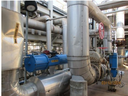
รูปที่ 3-35 Sound Insulation บริเวณ Steam Line
