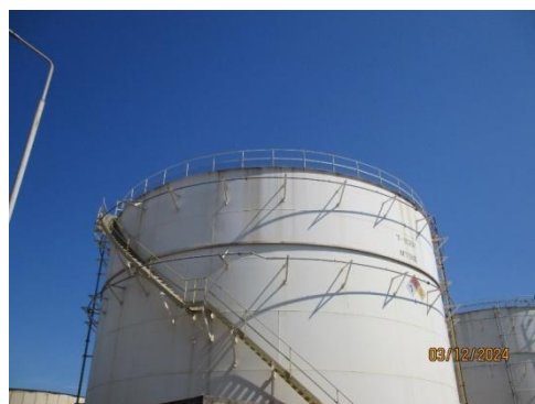
รูปที่ 3-44 ระบบโปรยน้ำดับเพลิง (Fire Water Sprinkle) สำหรับถังเก็บและหอกลับ
