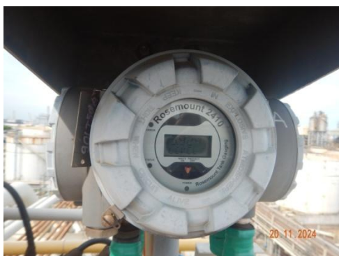
รูปที่ 3-68 อุปกรณ์วัดระดับ (Level Indicator) ที่ถังเก็บกัก
