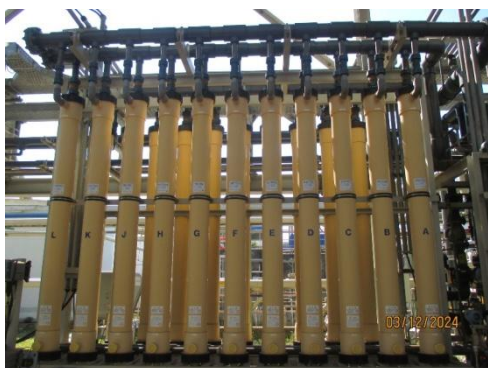
รูปที่ 3-15 ระบบกรองโดยใช้เยื่อเมมเบรน (Ultrafiltration)
