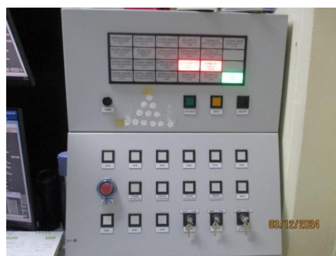
รูปที่ 3-10 Emergency Shutdown Push Button Switch ที่ห้องควบคุมกระบวนการผลิต
