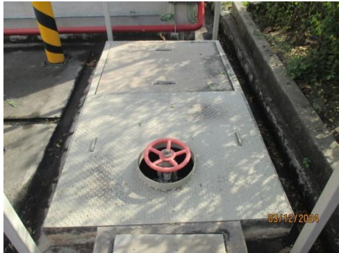
รูปที่ 3-29 บ่อ (Sump) สำหรับรวบรวมสารเคมีที่อาจหกั่วไหล
