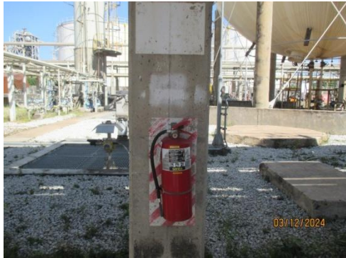
รูปที่ 3-47 ถังดับเพลิงผงเคมีแห้ง
