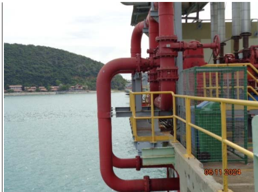
รูปที่ 32 ป้อนน้ำดับเพลิงและรถดับเพลิงฉุกเฉิน
