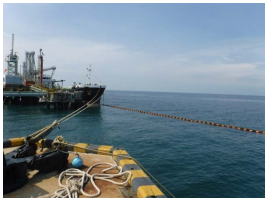
รูปที่ 38 การล้อมบูมในขณะสูบน้ำถ่ายผลิตภัณฑ์
