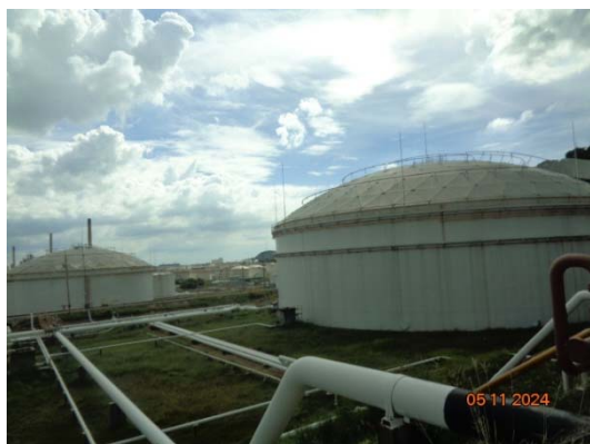
รูปที่ 1 ถังเก็บสารรองน้ำมันออกแบบให้มีความสูง 2 ชั้น เพื่อลดการปล่อยไอสารอินทรีย์ (VOCs)
