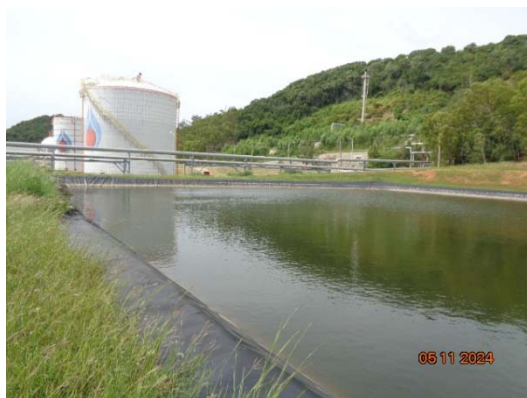
รูปที่ 35 บ่อสำรองน้ำดับเพลิง
