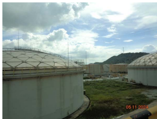
รูปที่ 1 ถังเก็บสารรองน้ำมันออกแบบให้มีความสูง 2 ชั้น เพื่อลดการปล่อยไอสารอินทรีย์ (VOCs)
