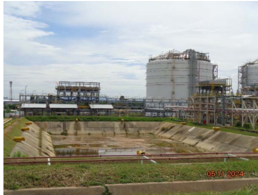
รูปที่ 29 บ่อกักเก็บก๊าซ กรณีผลิตภัณฑ์รั่วไหล
