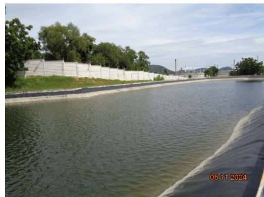
รูปที่ 35 บ่อสำรองน้ำดับเพลิง
