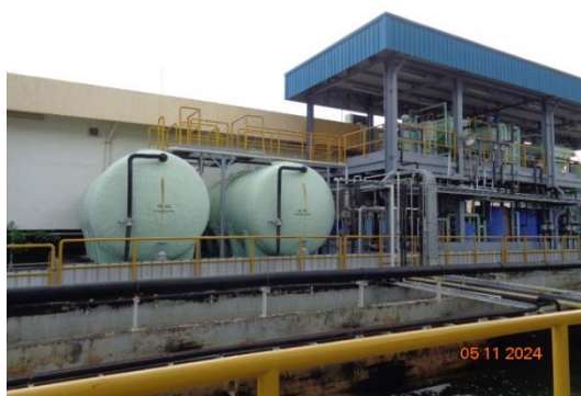
รูปที่ 4 ระบบบำบัดน้ำเสียภายในพื้นที่โครงการ
