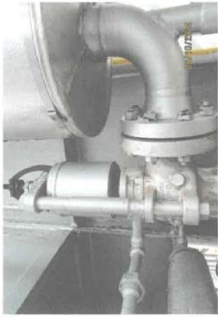
ตรวจสอบSafety Valve ต่างๆทำงานตามค่าที่กำหนด
