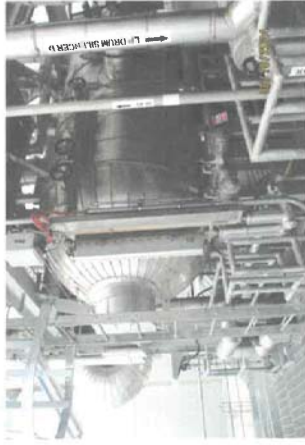
ตรวจสอบภายนอก Drum ต่างๆผลปกติ หม้อไอน้ำหมายเลข 6 (HRSG-06 ) บริษัท ราชพัฒนา เอ็นเนอร์ยี่ จำกัด (มหาชน) วันที่ 8 ตุลาคม 2567
