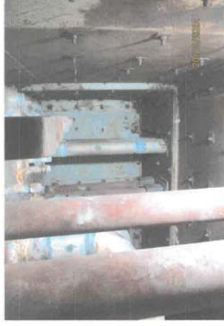
ตรวจสอบแนวเชื่อมทั่วๆไปภายในหม้อน้ำ ด้าน High Pressure หม้อไอน้ำหมายเลข 5 (HRSG-05) บริษัท ราชพัฒนา เอนเนอร์ยี่ จำกัด (มหาชน) วันที่ 20 ตุลาคม 2567
