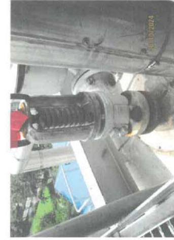
ตรวจสอบSafety Valve ต่างๆทำงานตามค่าที่กำหนด หม้อไอน้ำหมายเลข 5 ( HRSG-05 ) บริษัท ราชพัฒนา เอนเนอร์ยี่ จำกัด (มหาชน) วันที่ 20 ตุลาคม 2567
