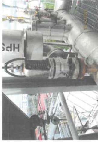
ตรวจสอบSafety Valve ต่างๆทำงานตามค่าที่กำหนด หม้อไอน้ำหมายเลข 5 ( HRSG-05 ) บริษัท ราชพัฒนา เอนเนอร์ยี่ จำกัด (มหาชน) วันที่ 20 ตุลาคม 2567
