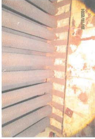
ตรวจสอบสภาพท่อต่าง ๆ เพื่อตรวจสอบการรั่วไหลของน้ำที่ความดันด้าน High Pressure หม้อไอน้ำหมายเลข 5 (HRSG-05) บริษัท ราชพัฒนา เอนเนอร์ยี่ จำกัด (มหาชน) วันที่ 20 ตุลาคม 2567
