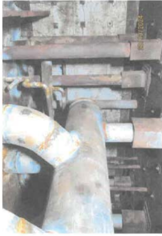
ตรวจสอบสภาพแนวเชื่อมท่อน้ำภายในหม้อน้ำ หม้อไอน้ำหมายเลข 5 ( HRS-G-05 ) บริษัท ราชพัฒนา เอ็นเนอร์ยี่ จำกัด (มหาชน) วันที่ 20 ตุลาคม 2567
