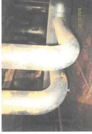
ตรวจสอบสภาพแนวเชื่อมท่อภายในหม้อน้ำ หม้อไอน้ำหมายเลข 6 ( HRS-G-06 ) บริษัท ราชพัฒนา เอ็นเนอร์ยี่ จำกัด (มหาชน) วันที่ 8 ตุลาคม 2567
