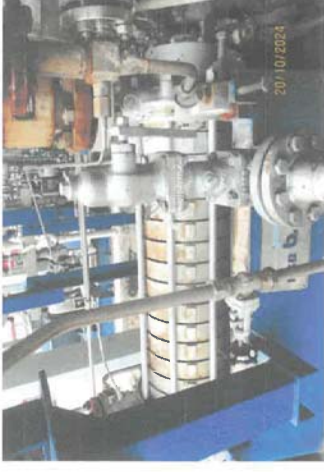
ตรวจสอบระบบ Boiler Feed Pump ผลปกติ หม้อไอน้ำหมายเลข 5 ( HRS-G-05 ) บริษัท ราชพัฒนา เอ็นเนอร์ยี่ จำกัด (มหาชน) วันที่ 20 ตุลาคม 2567
