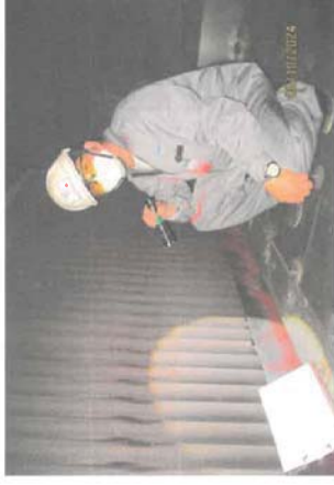
ตรวจสอบแนวเชื่อมทั่วๆไปภายในหม้อน้ำ ด้าน High Pressure หม้อไอน้ำหมายเลข 6 ( HRSG-06 ) บริษัท ราชพัฒนา เ็นเนอจี้ จำกัด (มหาชน) วันที่ 8 ตุลาคม 2567
