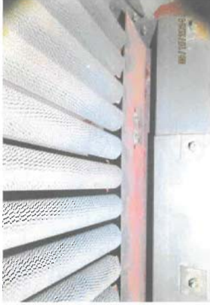
ตรวจสอบสภาพท่อไอน้ำต่างๆเพื่อตรวจสอบการรั่วหลังอัดน้ำที่ความดันกำหนด ด้าน High Pressure หม้อไอน้ำหมายเลข 6 ( HRSG-06 ) บริษัท ราชพัฒนา เ็นเนอจี้ จำกัด (มหาชน) วันที่ 8 ตุลาคม 2567
