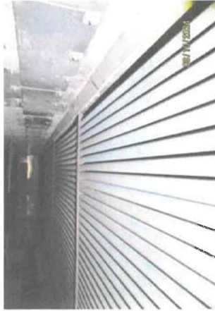
ตรวจสอบสภาพท่อไอน้ำด้าน High Pressure หลังทำHydrostatic Test ผลปกติไม่มีการรั่วใด ๆ หม้อไอน้ำหมายเลข 6 ( HRSG-06 ) บริษัท ราชพัฒนา เ็นเนอจี้ จำกัด (มหาชน) วันที่ 8 ตุลาคม 2567
