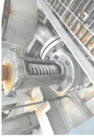
ตรวจสอบSafety Valve ต่างๆทำงานตามค่าที่กำหนด หม้อไอน้ำหมายเลข 5 ( HRSG-05 ) บริษัท ราชพัฒนา เอนเนอร์ยี่ จำกัด (มหาชน) วันที่ 20 ตุลาคม 2567
