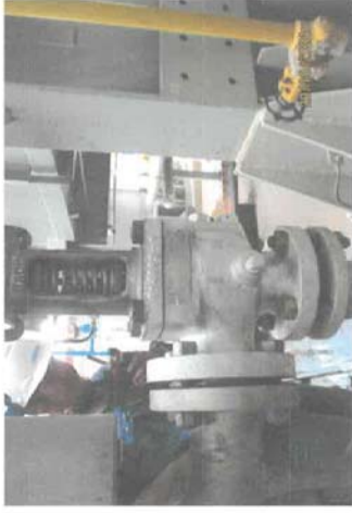
ตรวจสอบSafety Valve ต่างๆทำงานตามค่าที่กำหนด หม้อไอน้ำหมายเลข 5 ( HRSG-05 ) บริษัท ราชพัฒนา เอนเนอร์ยี่ จำกัด (มหาชน) วันที่ 20 ตุลาคม 2567
