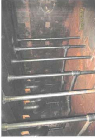
ตรวจสอบสภาพพ่อน้ำภายในหม้อน้ำ ด้าน Low Pressure หม้อไอน้ำหมายเลข 6 (HRSG-06 ) บริษัท ราชพัฒนา เอ็นเนอร์ยี่ จำกัด (มหาชน) วันที่ 8 ตุลาคม 2567
