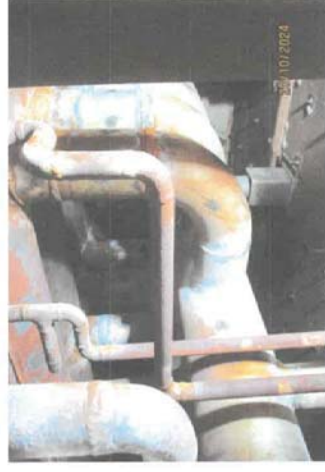
ตรวจสอบแนวเชื่อมทั่วๆไปภายในหม้อน้ำ ด้าน High Pressure หม้อไอน้ำหมายเลข 5 (HRSG-05) บริษัท ราชพัฒนา เอนเนอร์ยี่ จำกัด (มหาชน) วันที่ 20 ตุลาคม 2567
