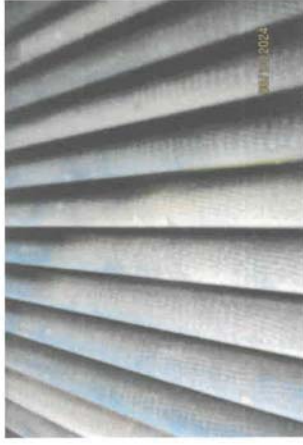
ตรวจสอบสภาพท่อภายในหม้อน้ำ ด้าน Low Pressure หม้อไอน้ำหมายเลข 6 ( HRS-G-06 ) บริษัท ราชพัฒนา เอ็นเนอร์ยี่ จำกัด (มหาชน) วันที่ 8 ตุลาคม 2567
