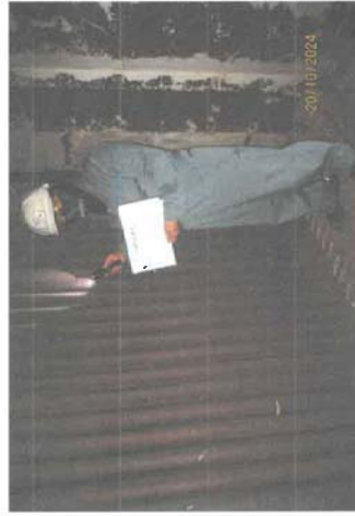
ตรวจสอบสภาพท่อด้าน High Pressure หลังทำ-Hydrostatic Test ผลปกติไม่มีการรั่วใด ๆ หม้อไอน้ำหมายเลข 5 (HRSG-05) บริษัท ราชพัฒนา เอนเนอร์ยี่ จำกัด (มหาชน) วันที่ 20 ตุลาคม 2567
