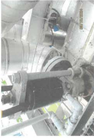
ตรวจสอบSafety Valve ต่างๆทำงานตามค่าที่กำหนด
