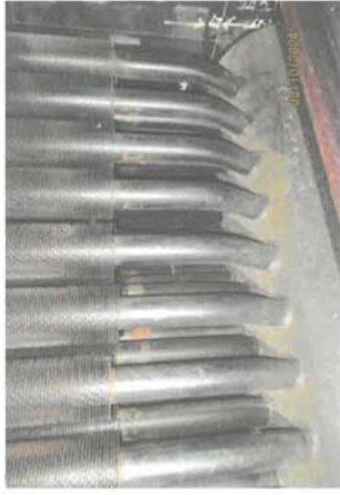
ตรวจสอบสภาพแนวเชื่อมท่อภายในหม้อน้ำ หม้อไอน้ำหมายเลข 6 ( HRS-G-06 ) บริษัท ราชพัฒนา เอ็นเนอร์ยี่ จำกัด (มหาชน) วันที่ 8 ตุลาคม 2567
