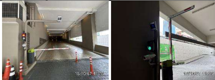
รูปที่ ผ7.13 ระบบไม้กั้นรถอัตโนมัติแบบบลูทูธ (Bluetooth Barrier Gate)
