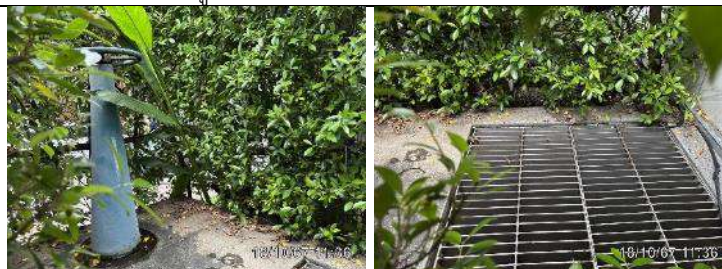
รูปที่ ผ7.11 ตะแกรงดักมูลฝอย
